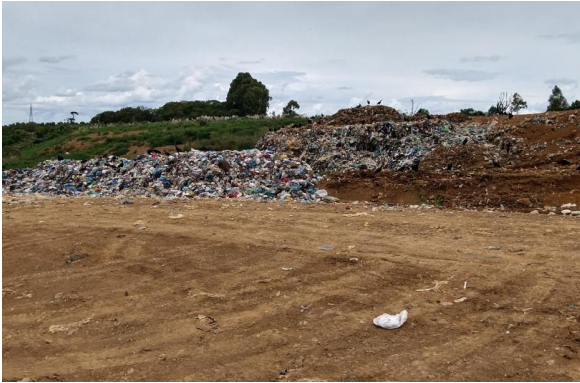
Figura 40 - Aterro Sanitário - Visita realizada no dia 02/02/2021.
