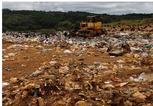
Figura 46 - Trator realizando a compactação.
