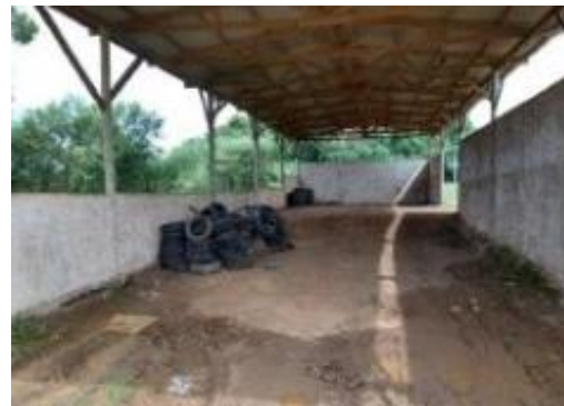
Figura 29 - Galpão de armazenamento de pneus cheio.
