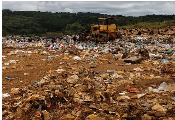
Figura 46 - Trator realizando a compactação.
