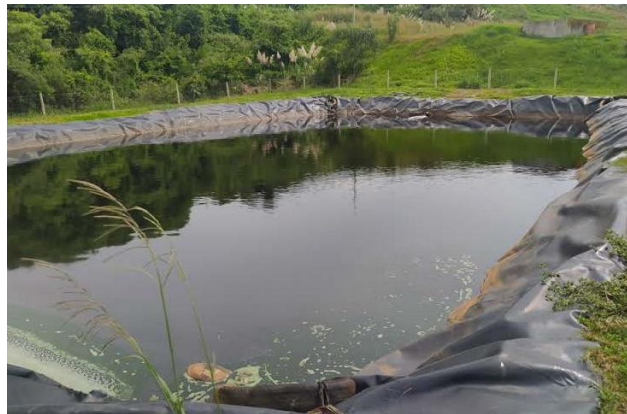
Figura 42 - Manta impermeável da lagoa de estabilização de forma regular.
