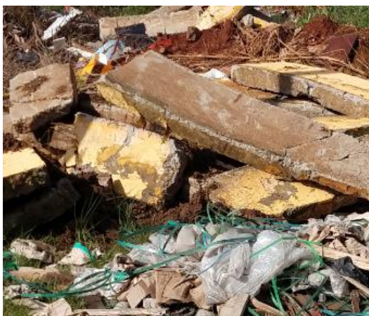
Figura 4 – RCC, Volumosos e Podas em terreno baldio.
