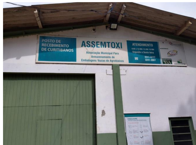
Figura 34 - Galpão da ASSEMTOXI.
