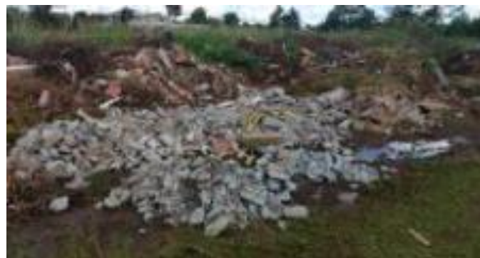
Figura 26 - Grande acúmulo de RCC no município.
