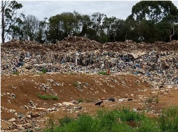
Figura 44 - Célula em processo de cobertura.
