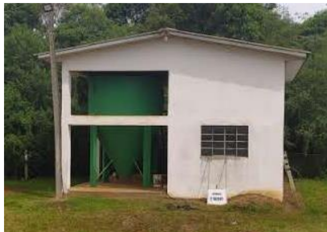
Figura 43 - Tratamento físico-químico inoperante.
