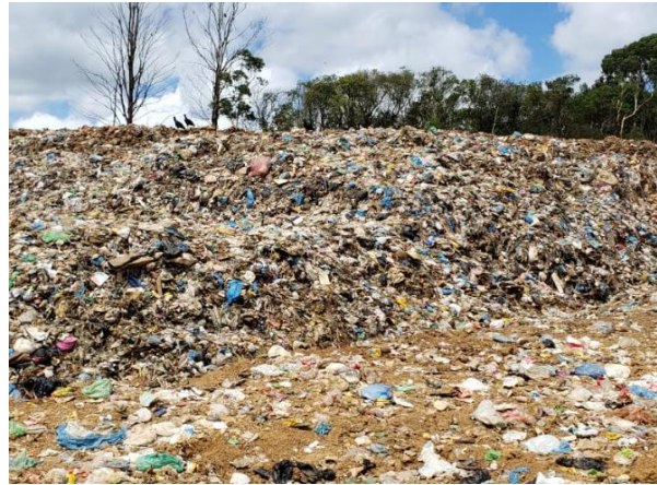
Figura 45 - Célula aguardando compactação para cobertura.
